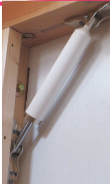
市場で求められる用途を探るため「自由設計オイルダンパー」として展示会に出展したところ、建材メーカーから声がかかり、地震対策となる木造住宅用制振ダンパーが誕生
