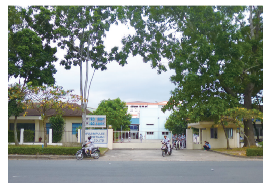
富士インパルス・ベトナムのゲート正面。プリント基板のアッセンブリやインパルスシーラーの組み立てを行っている。
