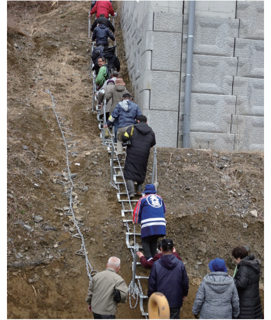
特殊な工事が不要で簡単な設置が可能な、簡易設置式くさり階段「逃げるんだ・登るんだ」。設置前と設置後では約30%以上の登坂スピードUPを実現している
