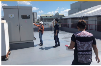
工場のあちこちに張り紙をして、人が倒れていないかなど異常を確認し合う被災状況確認の訓練も実施 ●株式会社三木製作所
